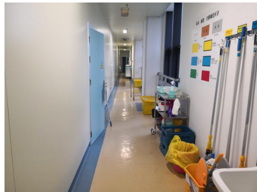
拟建 Allura XperFD20 型 DSA 机房南侧污物通道
