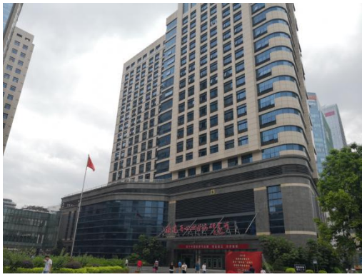
心血管病研究所大楼（6号楼）
