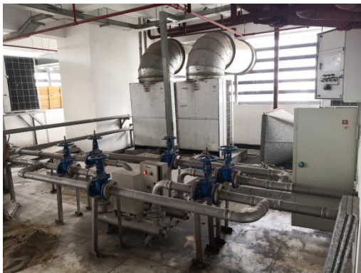
拟建 Allura Xper FD20 型 DSA 机房上方设备层
