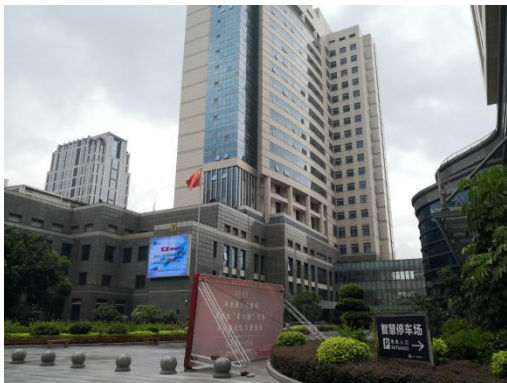
南侧 45m 住院大楼
