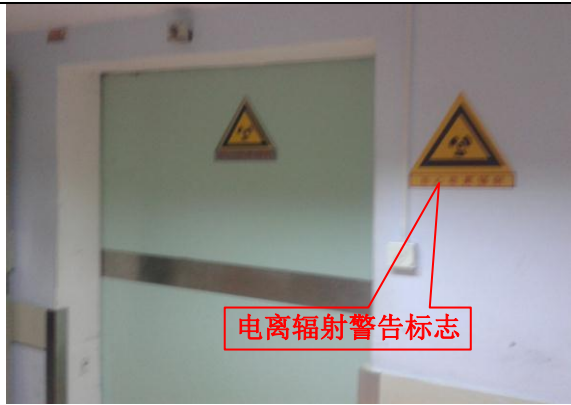
照片 4-54 螺旋 CT 病人出入防护门
