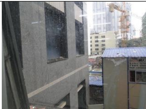
照片 4-24 甲癌治疗室西侧外墙
