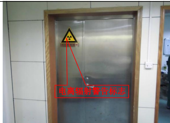
照片 4-88 DIAGNOST 胃肠机病人防护门
