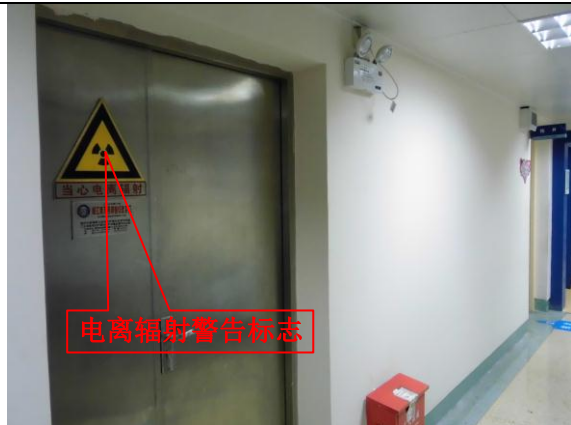
照片 4-78 岛津 RADSPED/DR 病人防护门
