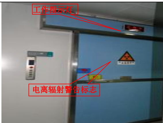
照片 4-6 ECT（二）机房门口
