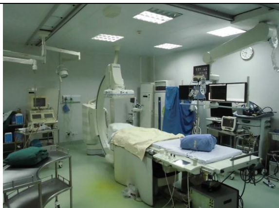
照片 4-39 FLOOR 型 DSA 机房
