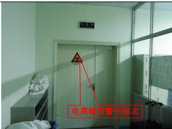
照片 4-49 LEILING 型 DSA 病人进出防护门
