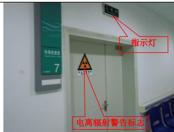
照片 4-94 Axiom Luminos drf X 光机防护门
