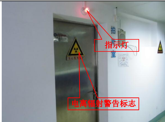
照片 4-75 VD150L-30E X 光机病人防护门
