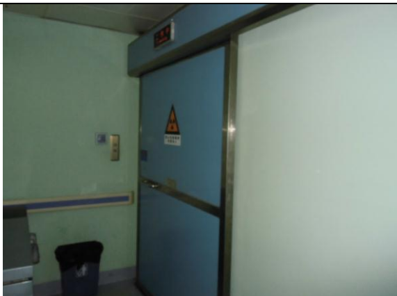
照片 4-23 甲癌治疗室东侧出入防护门
