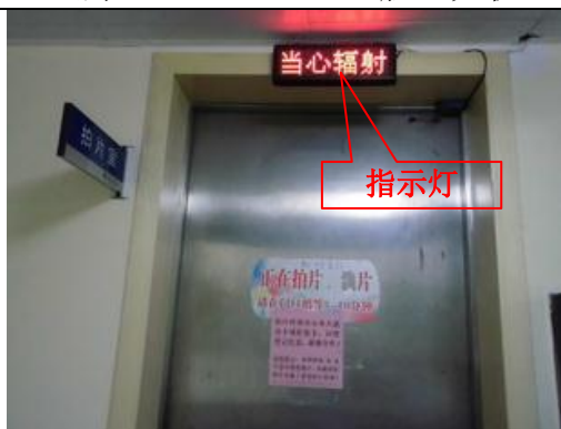
照片 4-97 ELITYS 口腔 X 光机防护门
