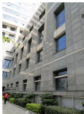
照片 4-46 DSA 机房西侧外墙
