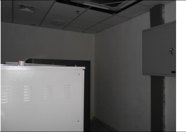
照片 4-116 机房北防护墙
