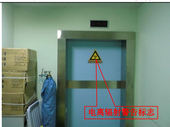
照片 4-41 FLOOR 型 DSA 病人出入防护门
